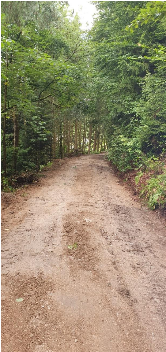
Abbildung 19: Wegeabschnitt für Wasser-ableitungsmaßnahme (Hof Bolkart)
